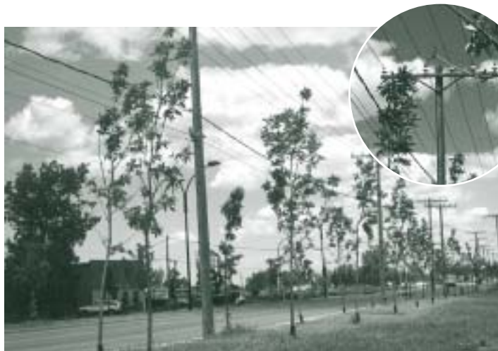
Exemple d'aménagement ne respectant pas les distances de dégagement sécuritaire.
