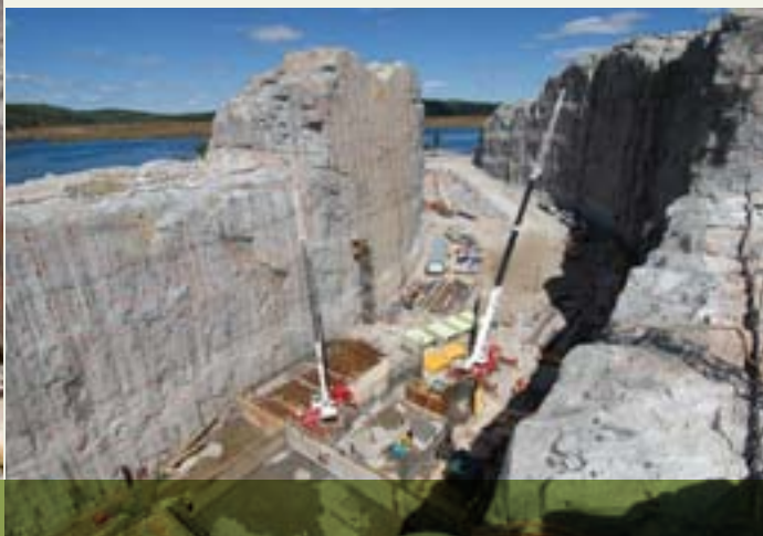
Chantier de l'Eastmain-1-A-Sarcelle-Rupert
