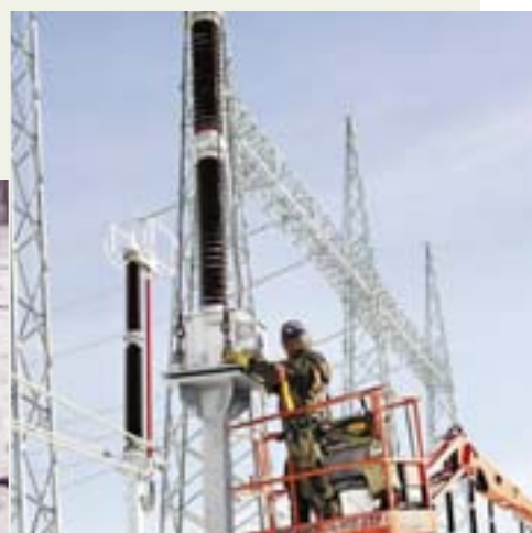
Construction du poste de l'Outaouais
