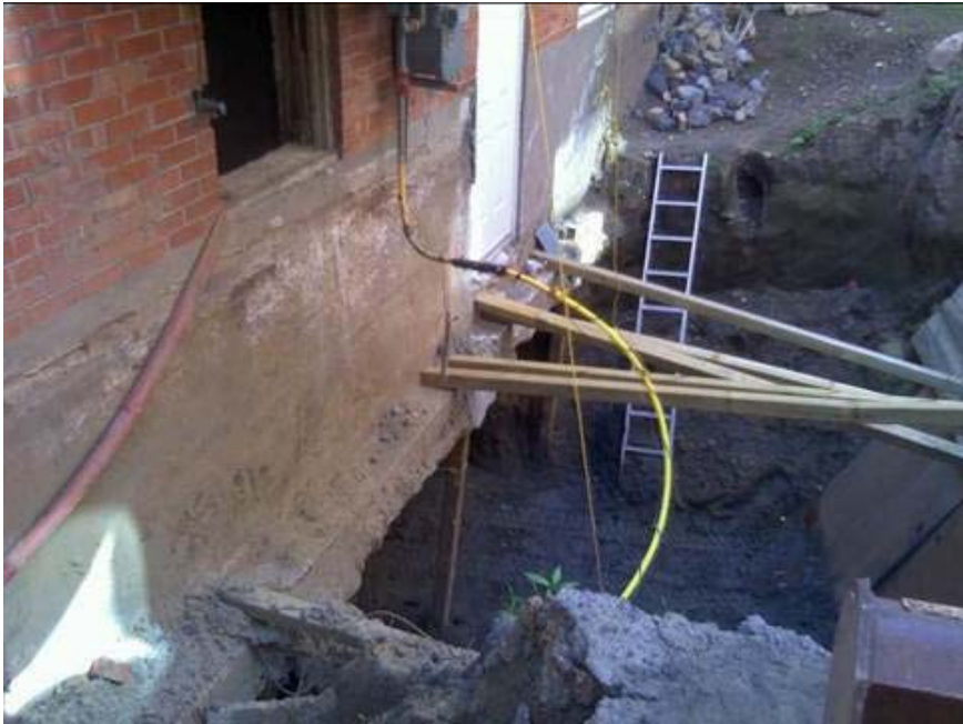
Compteur situé au-dessus d'une excavation
