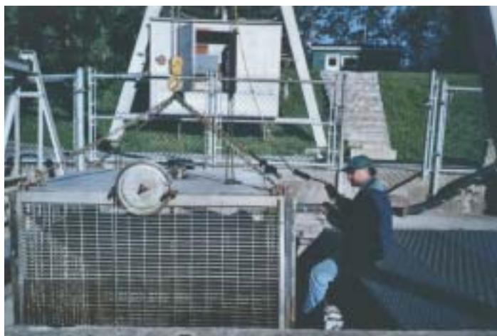
La cage de capture permet la remontée des saumons en amont des centrales hydroélectriques.
