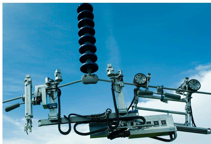
Franchissement d'une chaîne d'isolateurs
