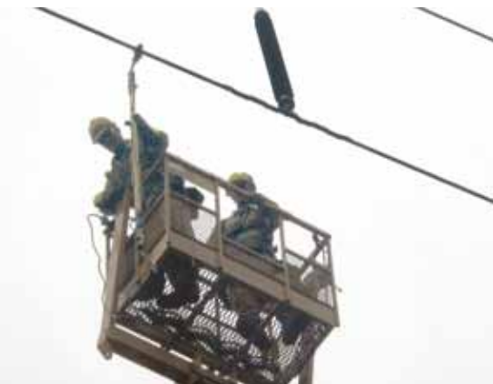
Installation d'une entretoise interphases
