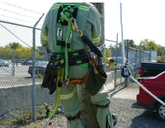
Utilisation de la corde d'assurance verticale pour grimper au poteau de bois
