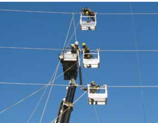
Installation d'accessoires et de capteurs à l'aide d'une nacelle élévatrice
