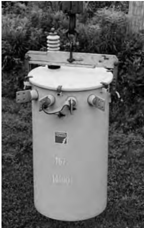
Arrimage d'un transformateur à l'aide d'un palonnier
