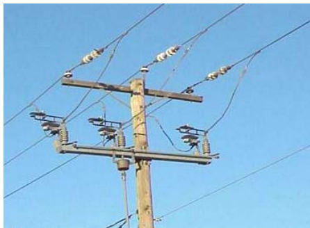
Interrupteur tripolaire S&C enlevé et même assiette
