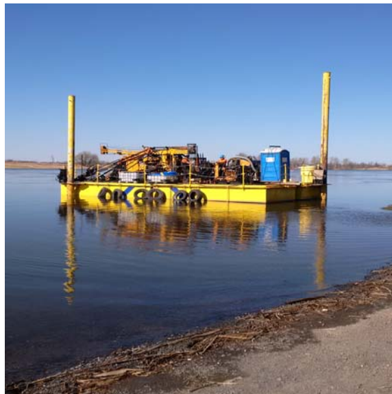
Barge utilisée pour le forage
