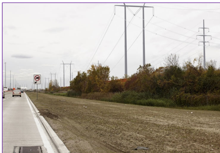
Simulation - Autoroute 40 : portique de ligne à 735 kV (à gauche) et pylône de ligne à 315 kV (à droite)
