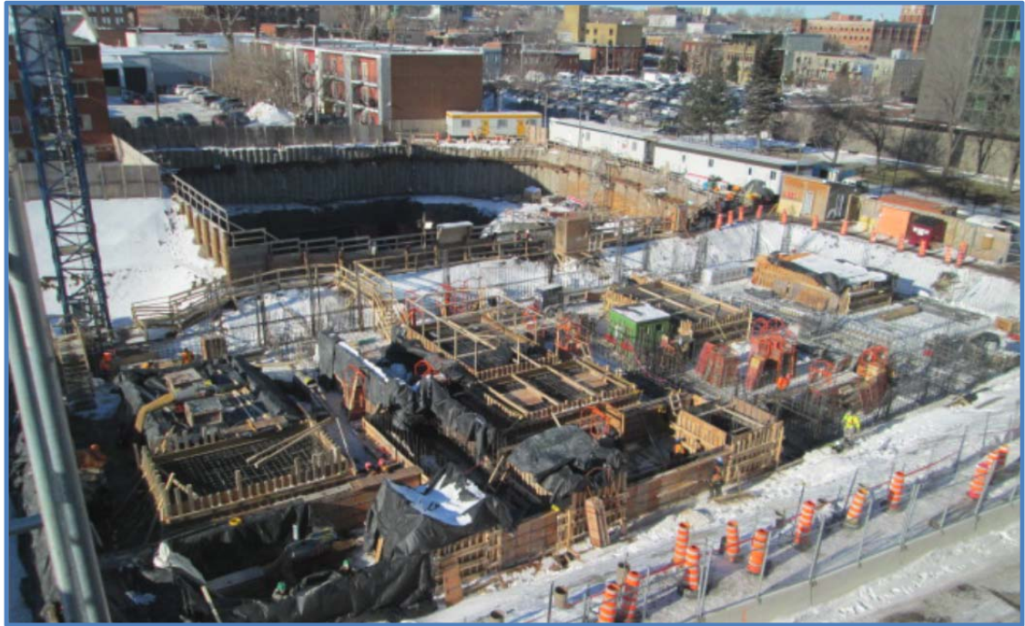
Bétonnage des fondations - base de transformateurs
