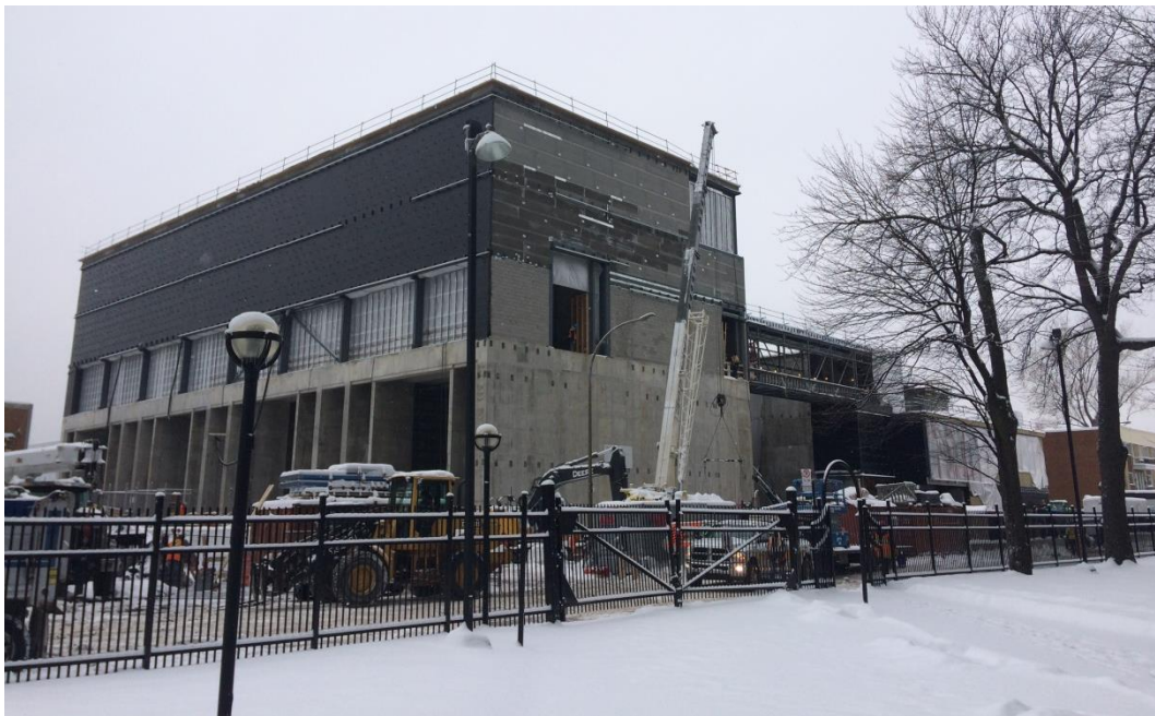
Construction des bâtiments à 25 kV et à 315 kV
