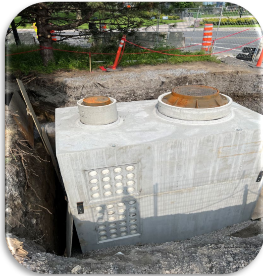
Travaux de construction de canalisations et des chambres souterraines
