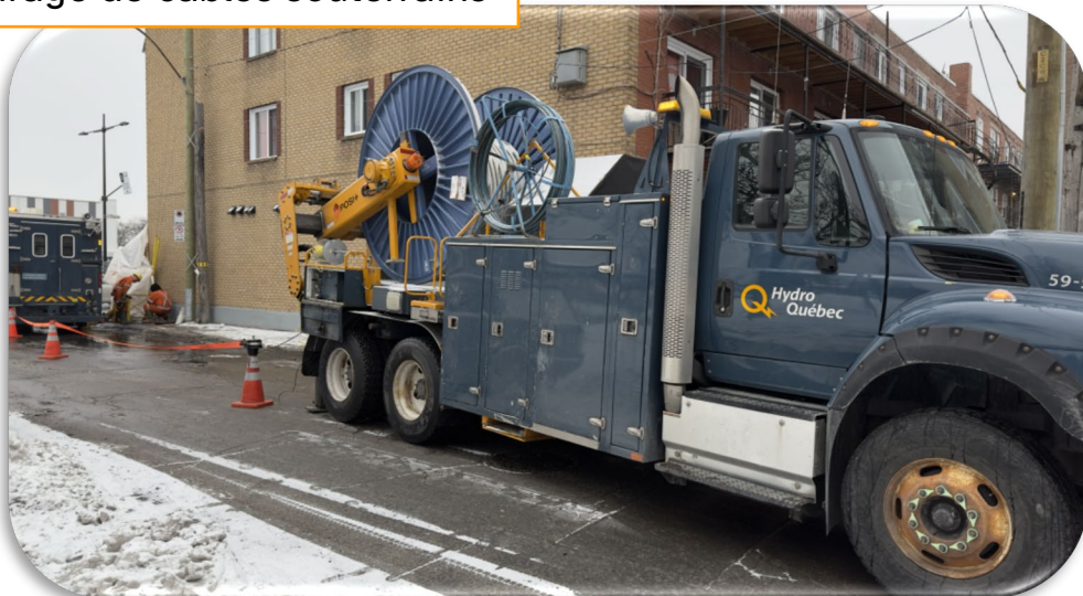
Tirage de câbles souterrains
