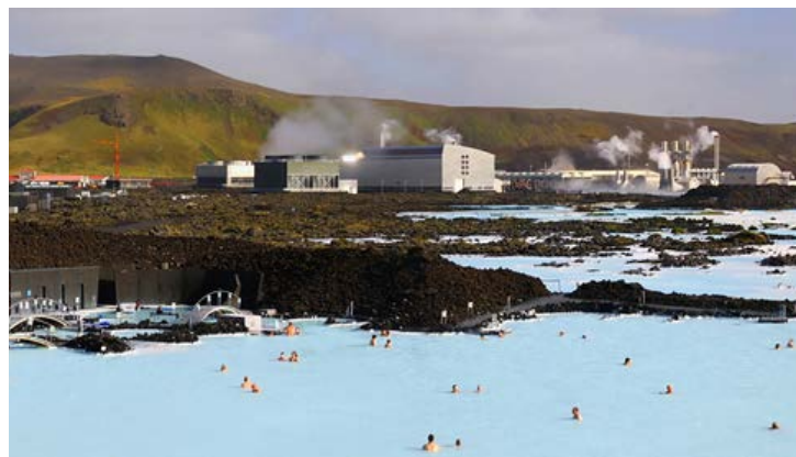
En couverture : Centrale géothermique d'Olkaria II, Kenya.
