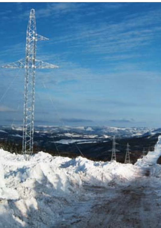
◀ En Gaspésie et dans le Bas-Saint-Laurent. Vue de la ligne au Goémon–Gros-Morne avant la pose des conducteurs.
