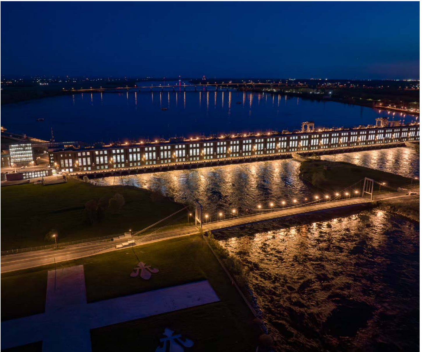
La centrale de Beauharnois.
