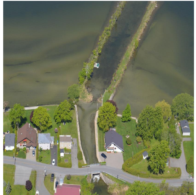
Canal Saint-Louis, canal d'amenée et barrage de Hungry Bay
