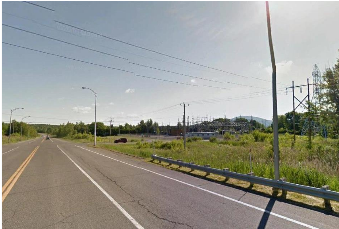
Photo 1 : Section de paysage 1 – Vue du poste de Cleveland depuis le boulevard Pierre-Laporte (point de vue 01)
