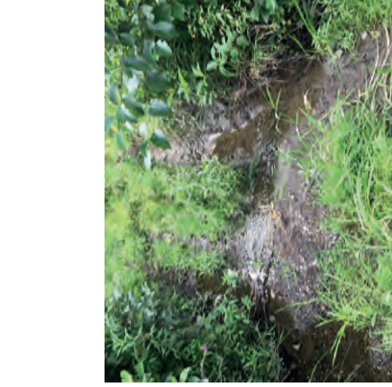
Photo 43 Chemin traversant le cours d'eau CE10
