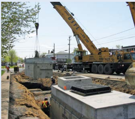
5. Installation des chambres de jonction
