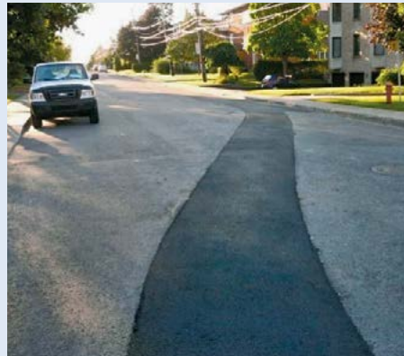
4. Remblayage et surfacage
