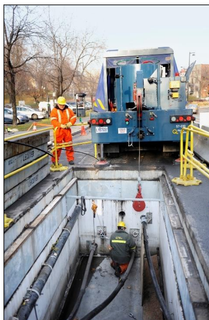
Installation de câbles électriques
