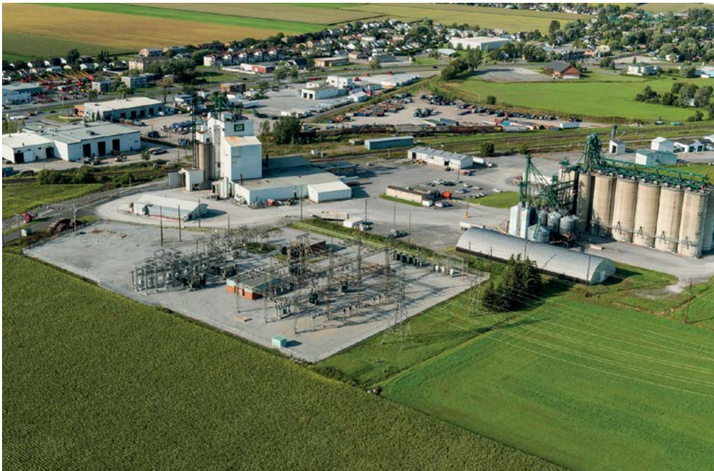
Poste de Sainte-Rosalie
