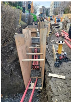
Reconstruction du réseau électrique souterrain.
