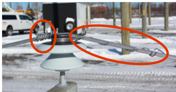
Relâchement des fils d'attache
