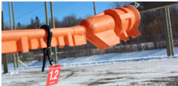
Protecteurs correctement installés
