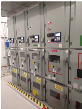
Système à deux disjoncteurs (norme E.12-08)
