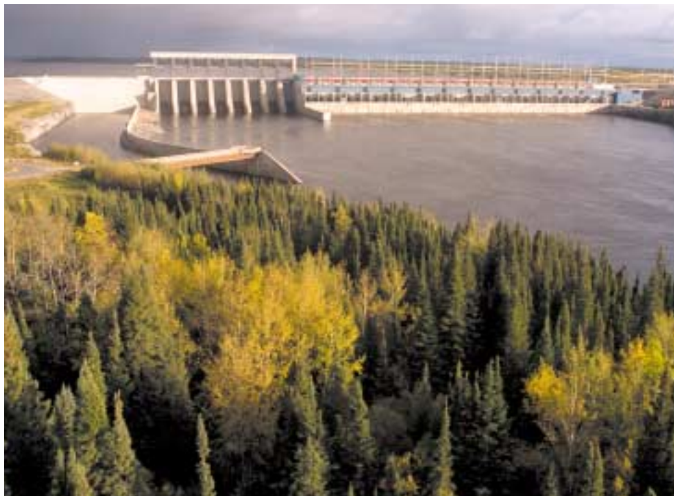
Vue de l'aval de l'aménagement hydroélectrique La Grande-1.
