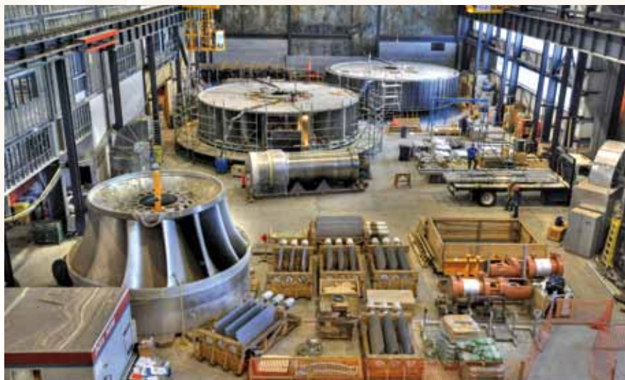
▲ Intérieur de la centrale de l'Eastmain-1-A, en construction.
